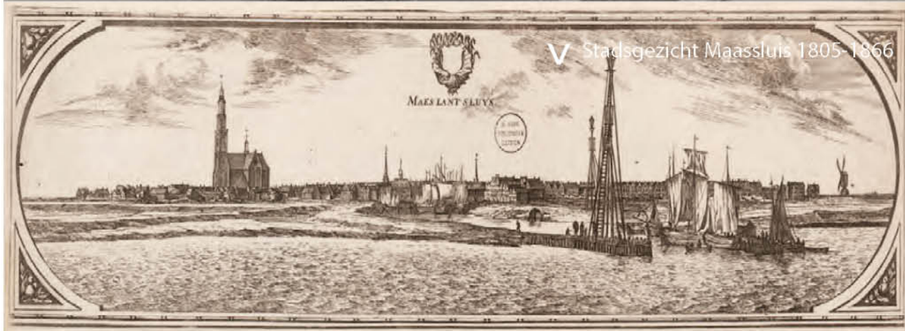
^ Oude Watertoren Maassluis
